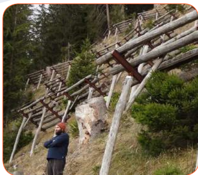
Barières anti-avalanches dans une forêt ayant subi un incendie dans les Alpes. Le changement climatique déclenche des incendies dans des endroits peu habituels. Auteur: E. Plana
